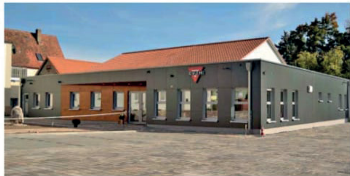
Das neue CVJM-Gemeindehaus dient als Begegnungsstätte für die gesamte Gemeinde. Fotos: Privat
